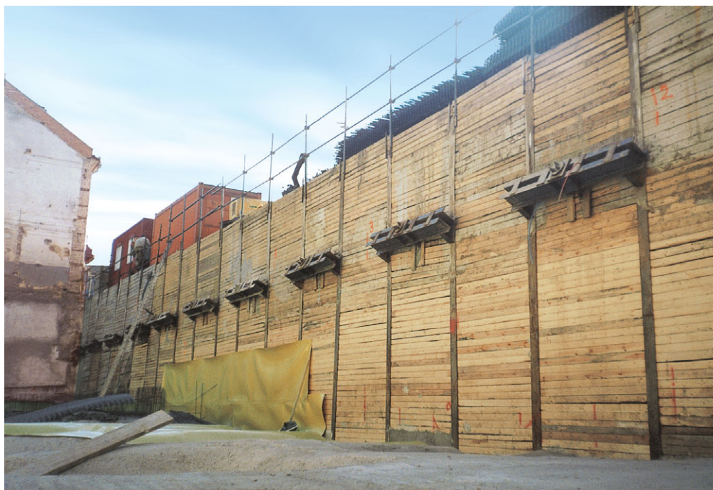
Ukázka kotvené záporové stěny (Pod Kotlaskou, Praha)
