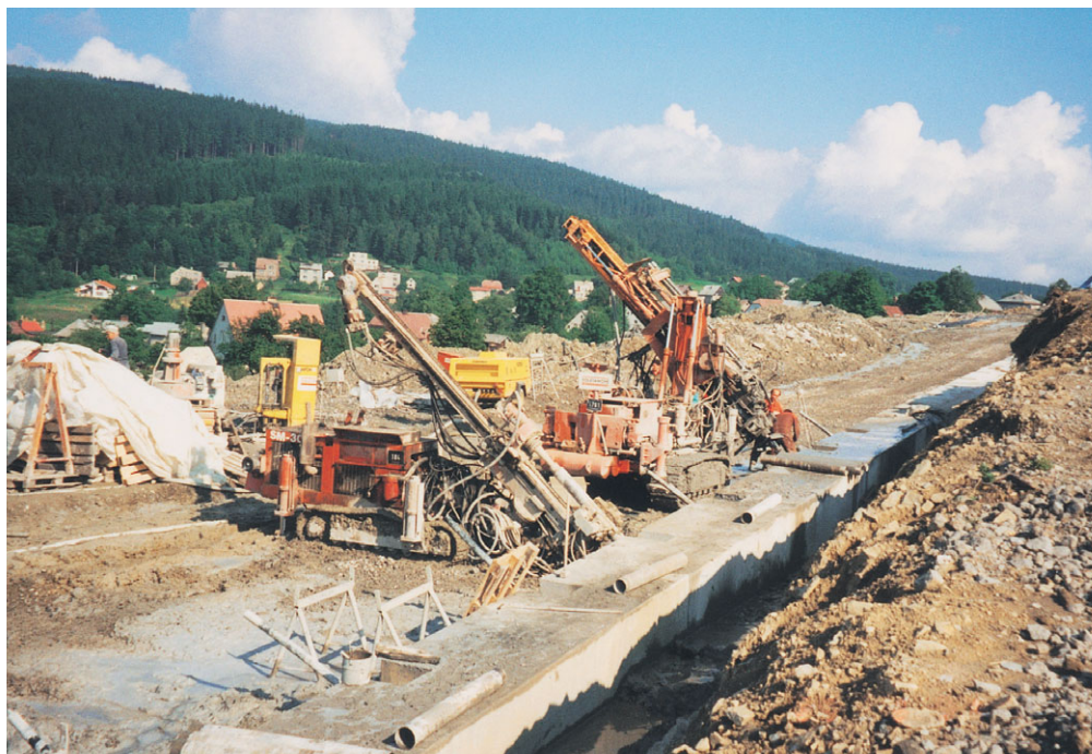
Kotvení pilotové stěny pro stabilizaci svahu (Mosty u Jablunkova)
